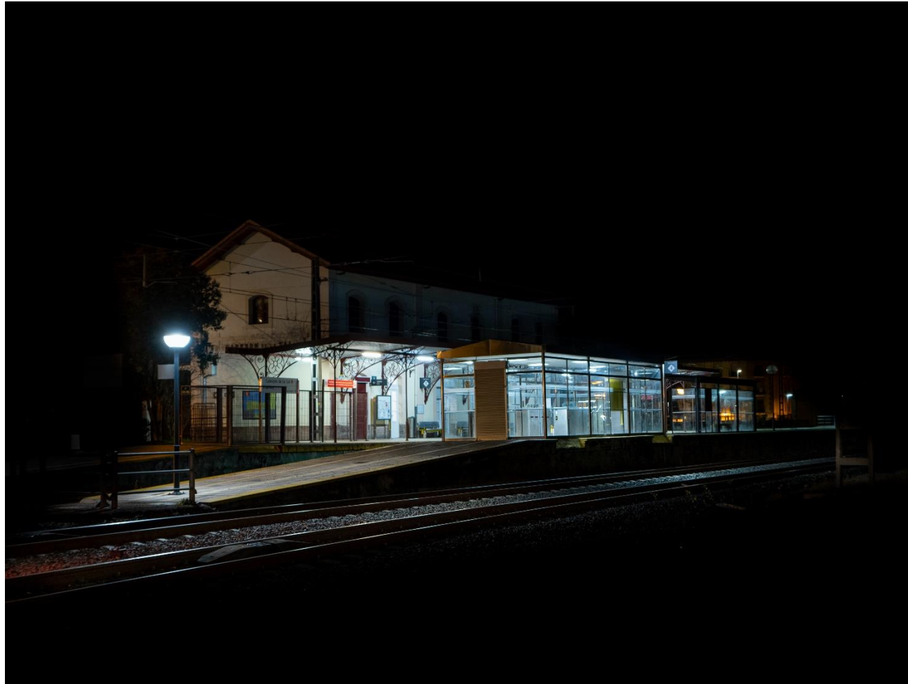
18 - CABEZÓN DE LA SAL 2023 – Estación de Ferrocarril
